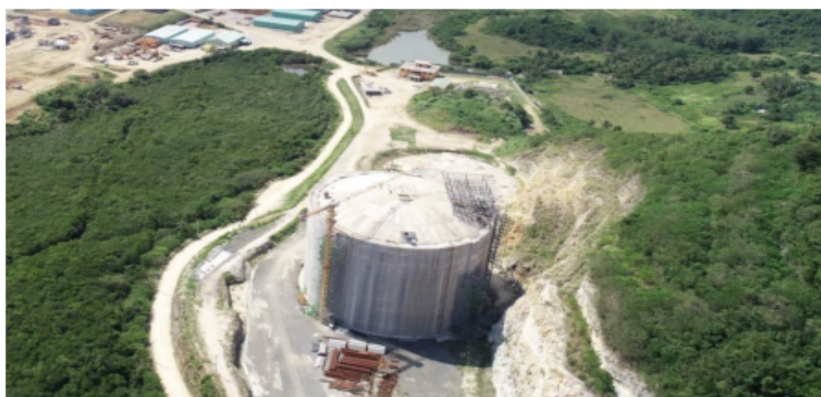
LNG Storage Tank
