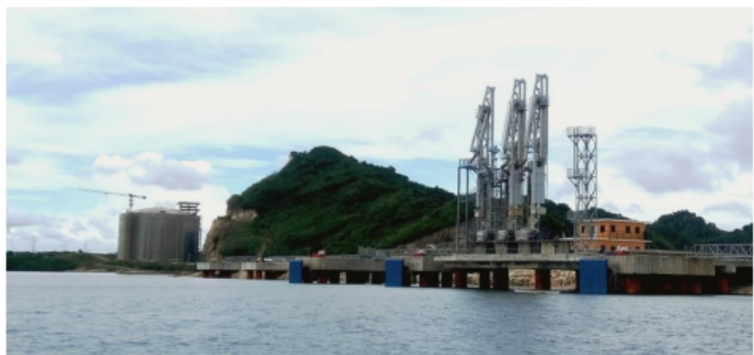
Erection of LNG Loading Arms
